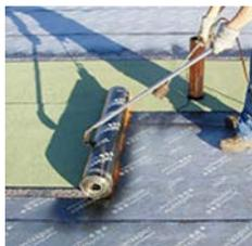
Hochwertige, wurzelfeste, grün beschieferte Oberbahn. Vollflächig im Schweissverfahren auf Unterbahn oder vorbehandelten Untergrund applizieren. Frei bewitterbare Oberbahn für: Flachdachabdichtung unter Dachbegrünung, Flachdach mit Gefälle < 1,5 % gemäss SIA271:2007 Ziffer 5.1, ein- oder mehrlagige Unterterrainabdichtung, ein- oder mehrlagige Auf- und Abbordung bzw. Dachrandabschluss als Oberbahn, einlagig und vollflächig auf starre vorbehandelte Unterkonstruktion (Beton) schweisssbar
