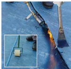
Dampfbremse oder Unterbahn mit oberseitigem Klebe- und Schweissvlies. Lose oder kaltselbstklebend verlegt, Überlappung kaltselbstklebend / Flammnaht. Je nach System wird die Folie flächig oder nur im Überlappungsbereich abgezogen. Längsüberlappungen: Kaltselfstklebender Teil mit Andrückrolle anpressen, Flammnaht verschweissen. Querüberlappungen mit Wärme aktivieren und verkleben. Verarbeitungstemperatur = 10°C. Bei tieferen Temperaturen sind Klebflächen mit Wärmezufuhr zu aktivieren
