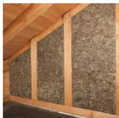
Wärme- und Schalldämmung im Zweischalenmauerwerk oder als Ausfachung in Holzkonstruktionen. Die standfeste, elastische Steinwollplatte 1 für den universellen Einsatz
