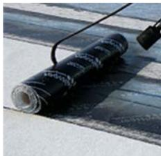
Hochwertige, hellgrau beschieferte, wirtschaftliche Schnellschweiss-Oberbahn. Vollflächig im Schweissverfahren auf Unterbahn applizieren. Frei bewitterbare Oberbahn für: Flachdachabdichtung unter bekiester oder begehrbarer Schutz- und Nutzsichten, Oberbahn auf mehrlagige Unterterrainabdichtung, mehrlagige Auf- und Abbordung bzw. Dachrandabschluss als Oberbahn, Flachdachabdichtung ohne Schutz- und Nutzsicht, Gefälle = 1.5 %
