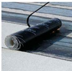
Hochwertige, wurzelfeste, hellgrau beschieferte, wirtschaftliche Schnellschweiss-Oberbahn. Vollflächig im Schweissverfahren auf Unterbahn applizieren. Frei bewitterbare Oberbahn für: Flachdachabdichtung unter Dachbegrünung, Flachdach mit Gefälle < 1,5 % gemäss SIA271:2007 Ziffer 5.1, ein- oder mehrlagige Unterterrainabdichtung, ein- oder mehrlagige Auf- und Abbordung bzw. Dachrandabschluss als Oberbahn.
