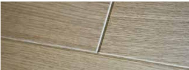
**Geräuchert:** Durch Oxidationsverfahren wird die natürliche Verdunkelung der Dielen beschleunigt. Dieser Effekt wirkt bis in einige Millimeter Tiefe, weshalb die Farbe dauerhaft erhalten bleibt.
